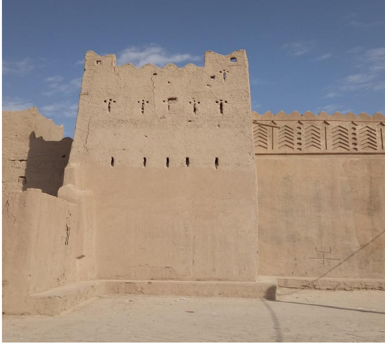
صورة 3: الزخرفة المعمارية تمثيل بصري المصدر: تصوير الباحث، 2023.
