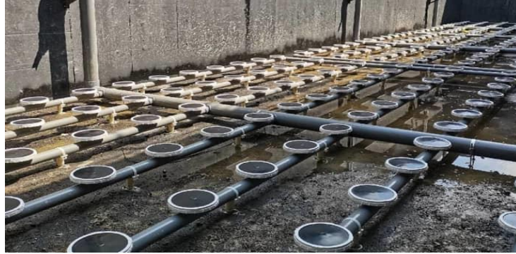
شكل (9): يبين طريقة التهوية بالهواء المضغوط
