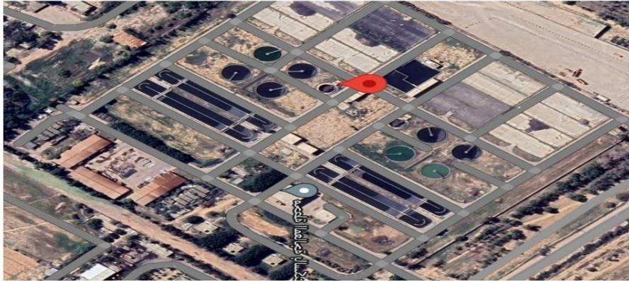
شكل (1): صورة للأقمار الصناعية لمحطة معالجة مياه الصرف.
