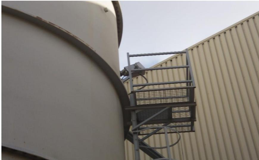
شكل (2): جهاز قياس انبعاث الغاز XNSA-308
